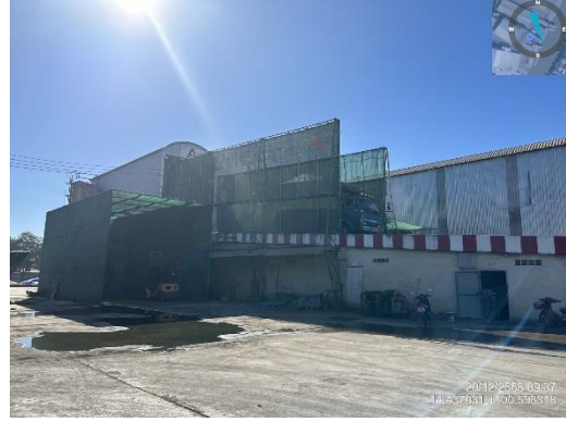
รูปที่ 2-7 เครื่องดักจับฝุ่น ติดกับโรงกลั่นค้ำ A พร้อมมีการติดตามถ่ายกันฝุ่นบริเวณทางขึ้นโรงกลั่นค้ำ A
