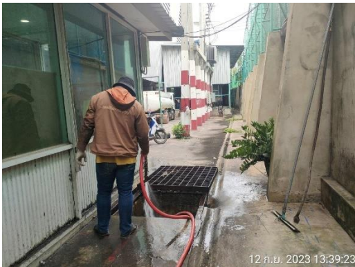
รูปที่ 2-32 ภาพการทำความสะอาดและขุดลอกท่อระบายน้ำ Manhole บ่อพักน้ำทิ้ง
