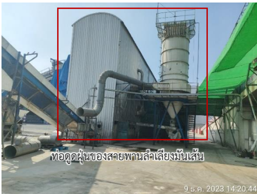
รูปที่ 2-8 เครื่องดักจับฝุ่น ติดกับโรงกลั่นค้ำ B พร้อมท่อดูดฝุ่นจากสายพานลำเลียงมันเส้น
