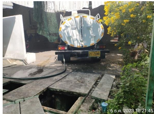
รูปที่ 2-32 ภาพการทำความสะอาดและขุดลอกท่อระบายน้ำ Manhole บ่อพักน้ำทิ้ง
