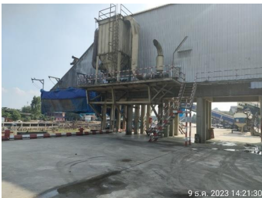
รูปที่ 2-7 เครื่องดักจับฝุ่น ติดกับโรงกลั่นค้ำ A พร้อมมีการติดตามถ่ายกันฝุ่นบริเวณทางขึ้นโรงกลั่นค้ำ A
